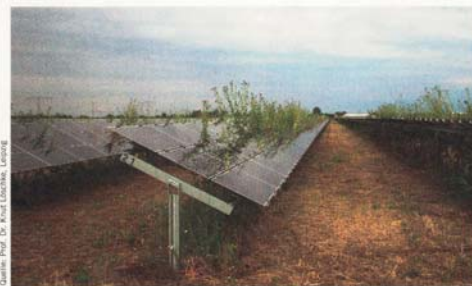
Bild 3: Nach einigen Jahren Betrieb kann man bei Freiflächenanlagen oft nicht mehr von einem »nicht brennbaren Untergrund« sprechen.
