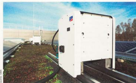
Bild 2: Der Wechselrichter »Sunny Tripower Core1« für maximal zwei Strings kommt ohne DC-Sicherungen aus.
